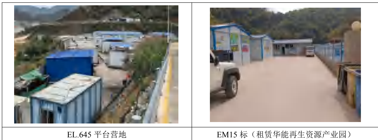
图 2.2-5 施工营地情况
