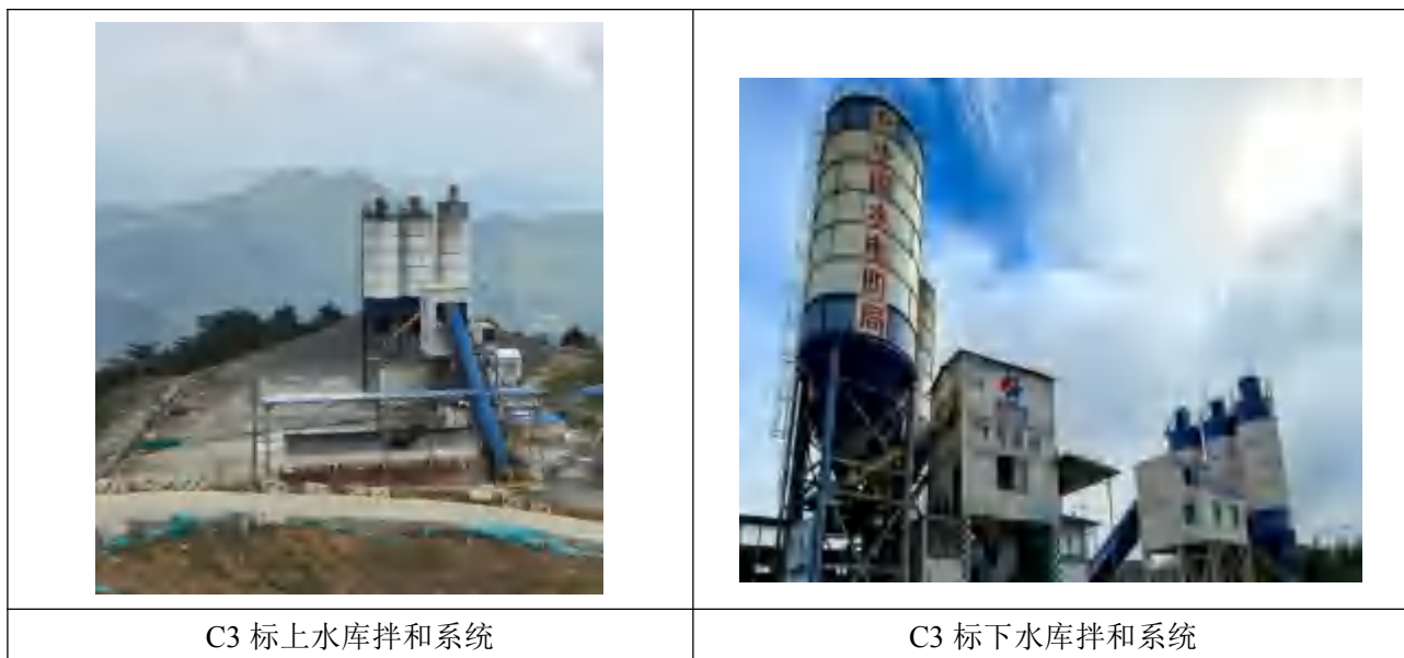
图 2.2-2 主要临建工程现状图片
