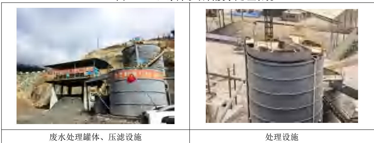
图 4.1-2 下水库砂石料废水处理系统
