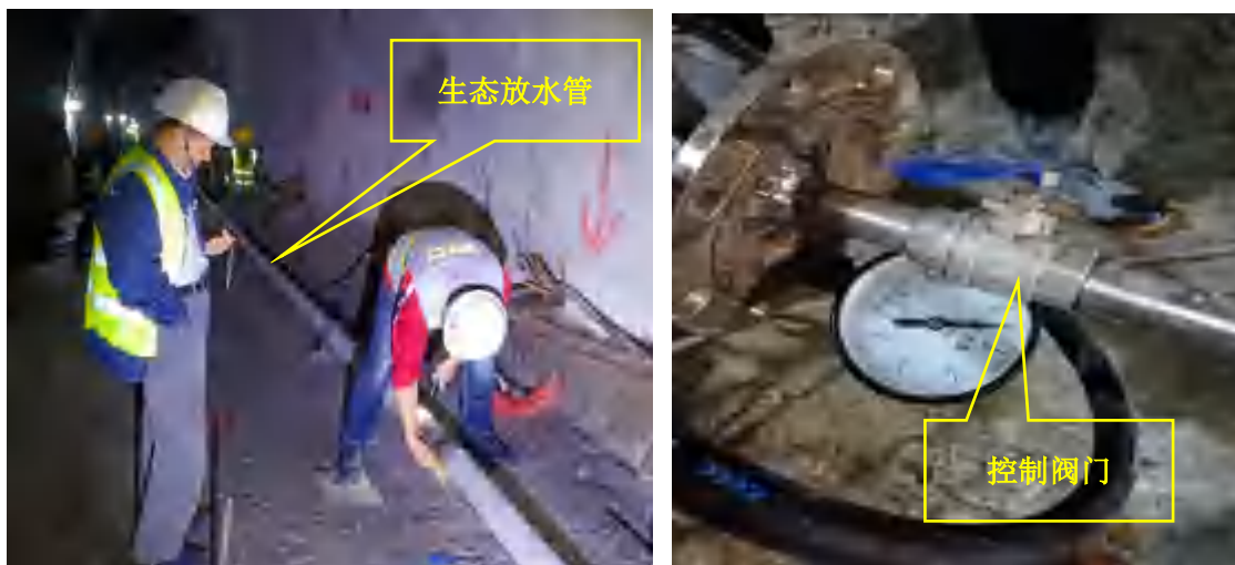
图 4.1-19 生态放水管施工过程图
