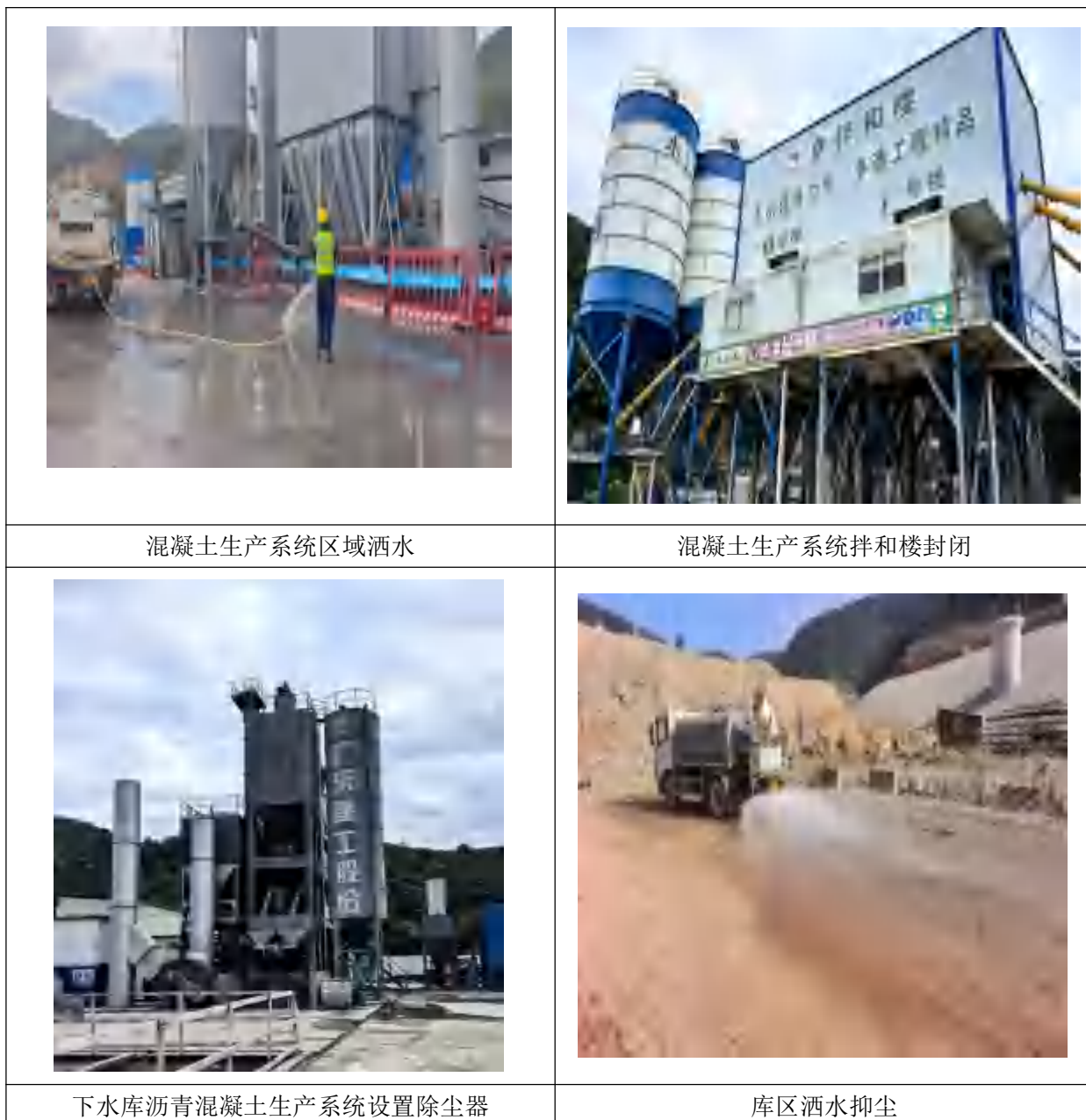
图 4.2-3 施工扬（粉）尘治理措施
