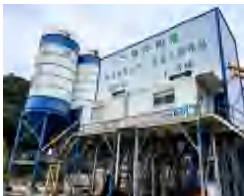
C2 标混凝土生产系统
