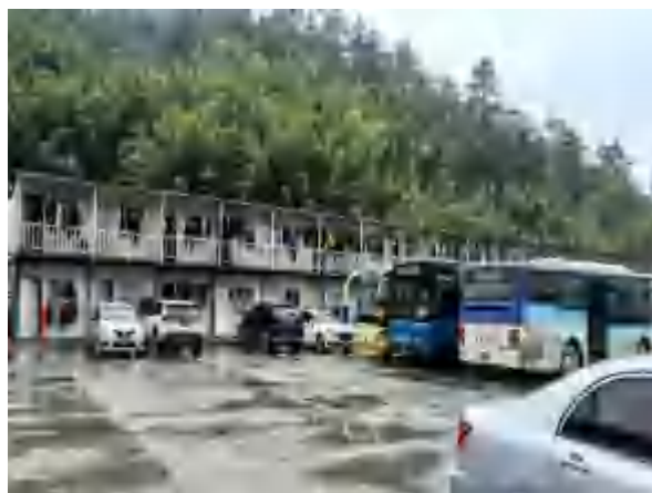
C3 标下水库临时营地
