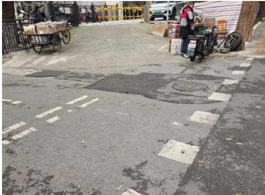
路面破除修复（1）
