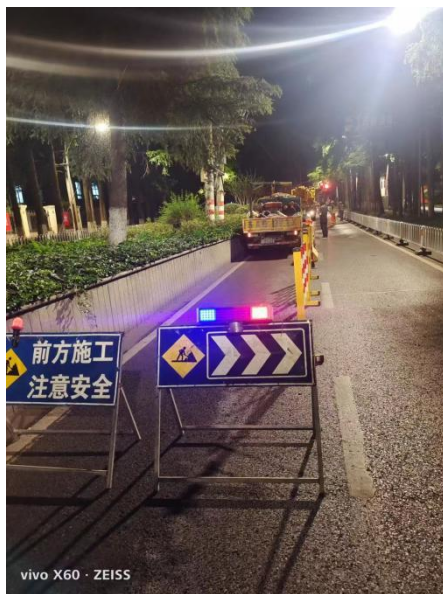
施工现场警示牌
