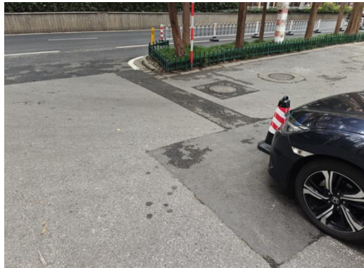
路面破除修复（3）
