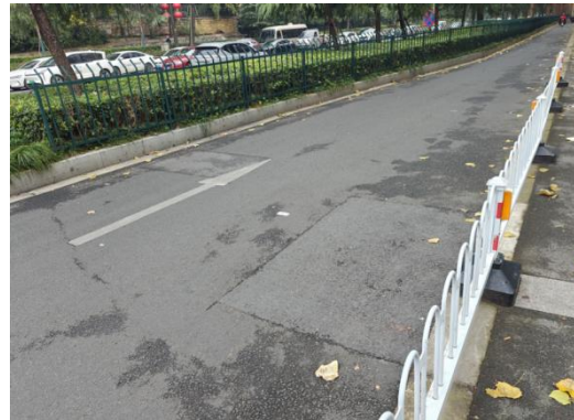
路面破除修复（4）
