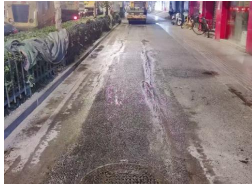
路面破除修复（2）
