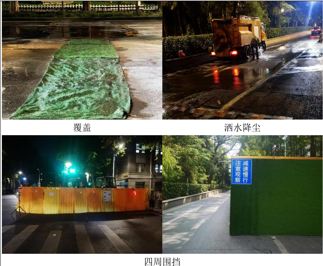
图 7.2-1 施工现场废气防治措施照片
