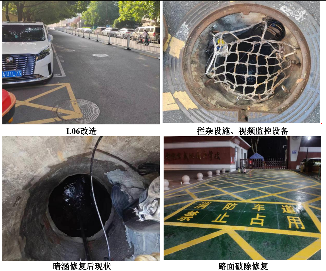
图4.1-1 工程完工后典型工程照片
