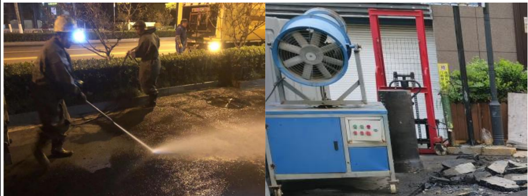
施工现场冲洗
