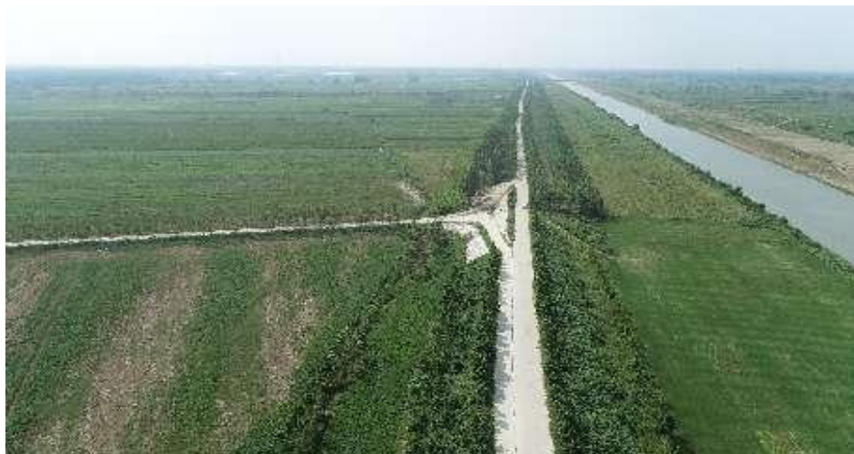
堤顶道路绿化
